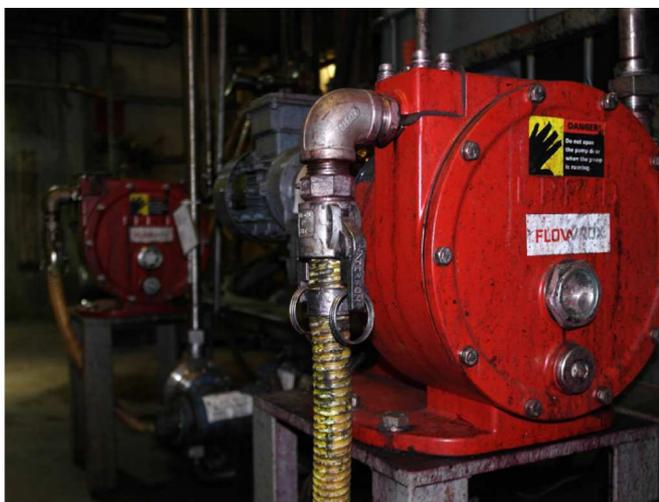
Surfactor utilise les pompes LPP-D pour le dosage des pigments de couleur et pour le dosage de la résine.
