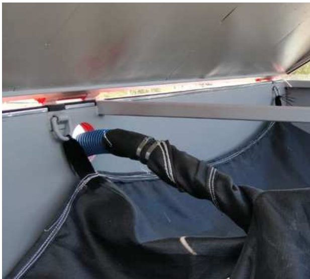
L'ouverture du sac filtrant en géotextile est fixée au niveau de l'orifice d'entrée des boues.
